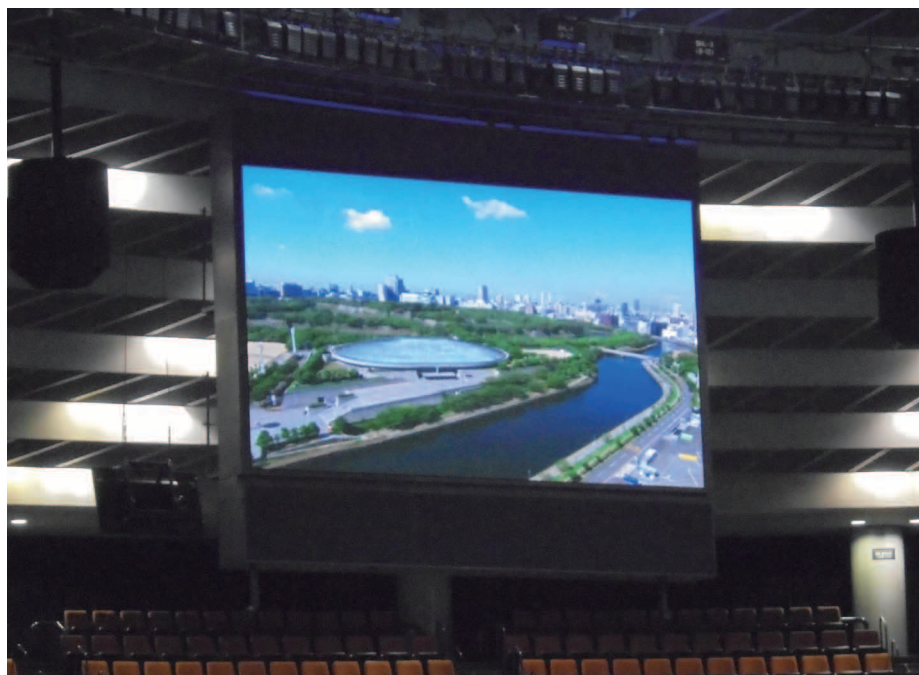
LEDビジョンのサイズは278インチ(W6,144mm×H3,456mm)で、輝度は3,000cd/m 2 以上。陸上などの競技における使用ではPCからの順位や成績といった競技情報を表示し、卒業式や入学式などのイベント時にはカメラからの場内映像を表示する。
